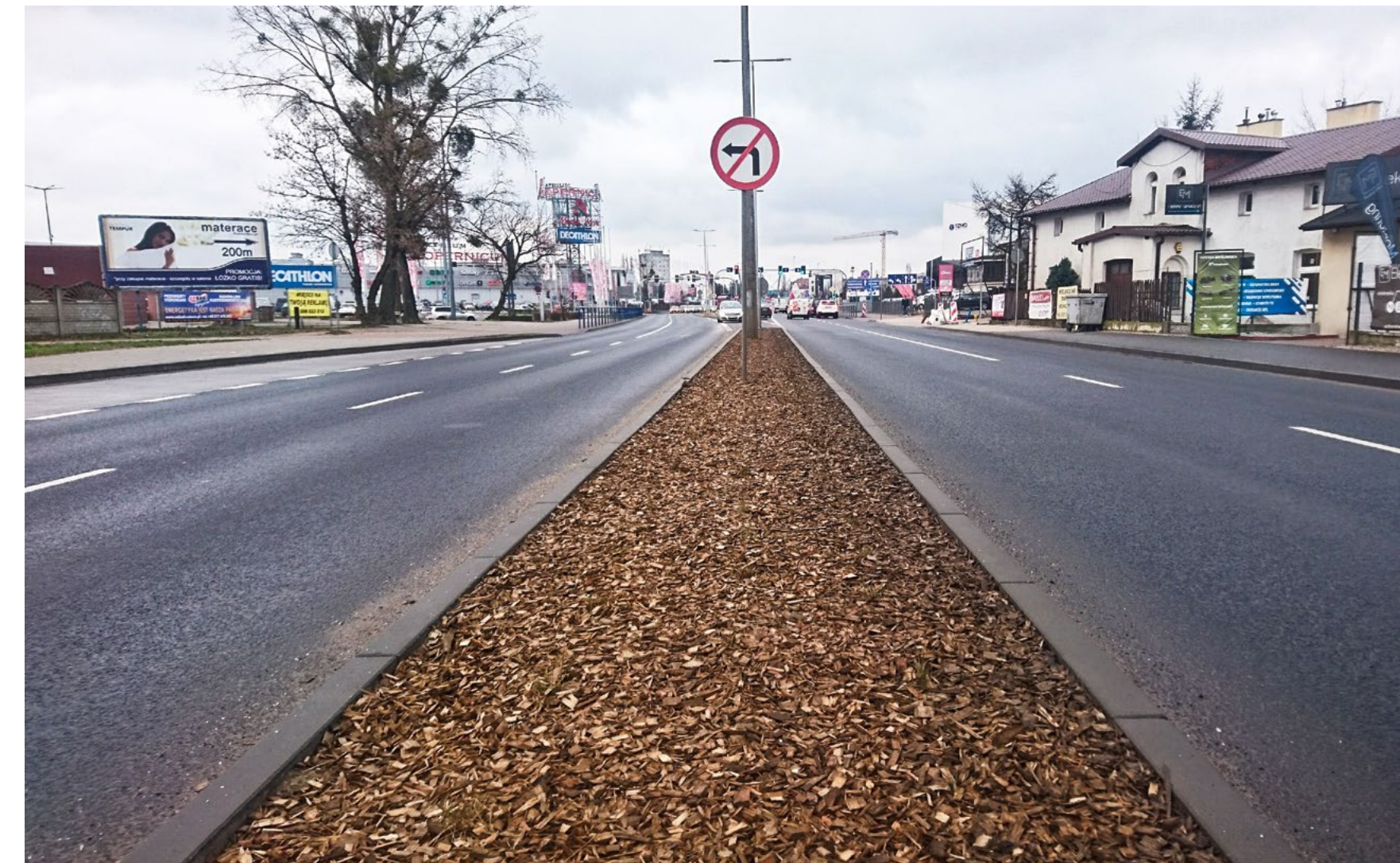
RENOVATION OF ŻÓŁKIEWSKIEGO STREET
