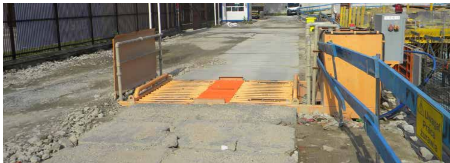
Przykład: Budowa CITY VIBE w Krakowie
